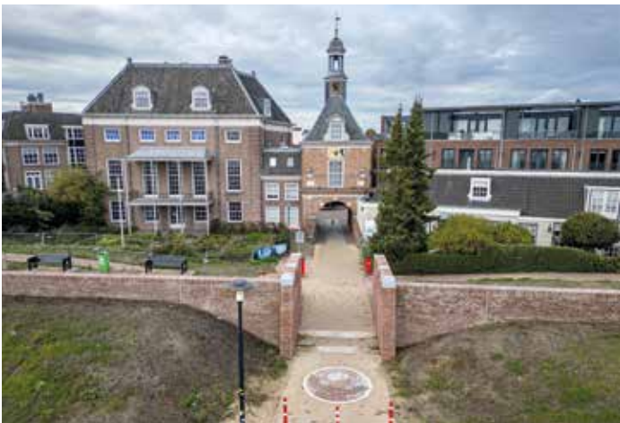
De vernieuwde Havendijk in 2024
